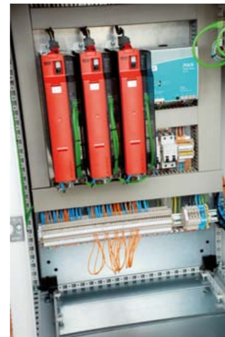
Utsnitt fra kontrollskap for servodrifter
